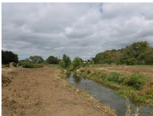
Vue en amont du plan d'eau, septembre 2016
