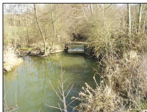
Ancien batardeau et bras de décharge
