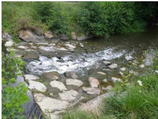
Vue du seuil en 2014
