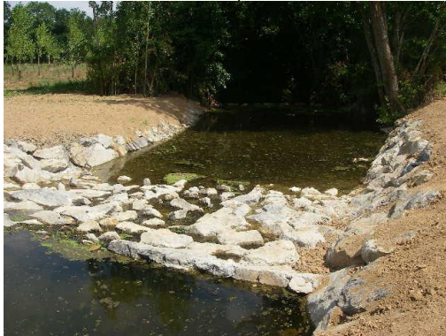
Vue de la rampe et du mini-seuil en 2010
