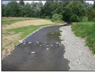
Amont passerelle, août 2013
