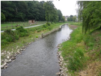
Aval passerelle, juillet 2014
