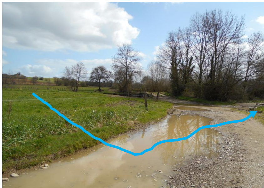
Vue du pont depuis le chemin communal (trajet de l'eau en crue en bleu) Haie et talus à supprimer à droite
