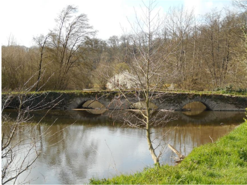
Vue du pont depuis l'amont
