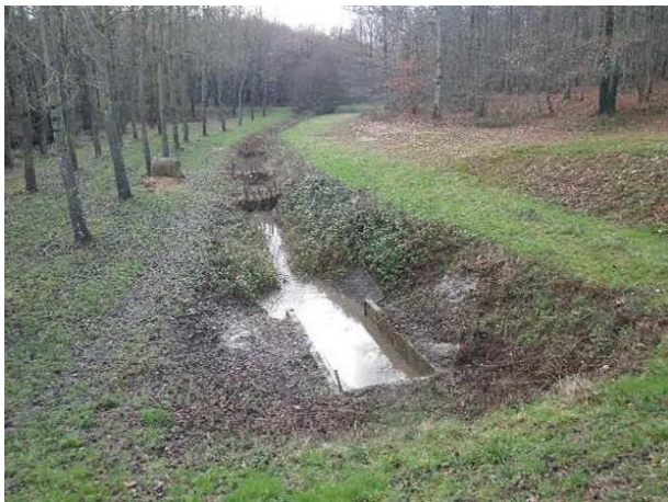
Exemple de mise en place de bottes de paille dans le lit de la rivière le Long (37), à l'aval d'un étang lors de sa vidange
